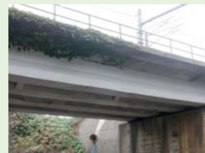
写真1 海岸沿いの橋梁外観
