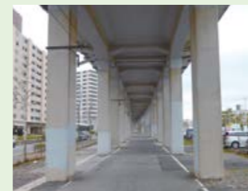
写真2 海岸に近い高架橋外観
