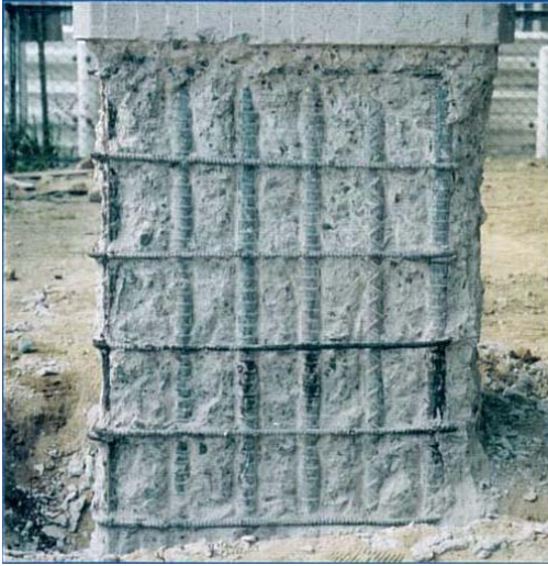
実際の鉄筋腐食状態
