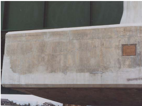
SAAR工法による補修完了状況
