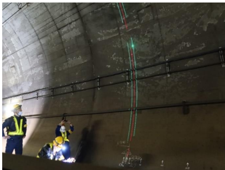
図1 内空断面の計測状況
